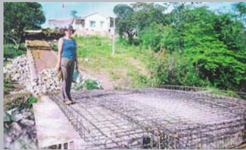
Juillet 2002 Construction du pont d'accès
